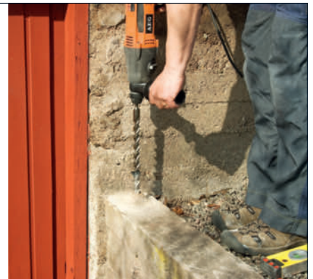
Pass på at hullene ikke sitter så langt ut at betongen sprekker.
