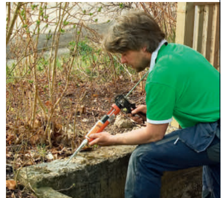
Limpatronen har en spiss, der de to delene blandes på vei ned i hullet.
