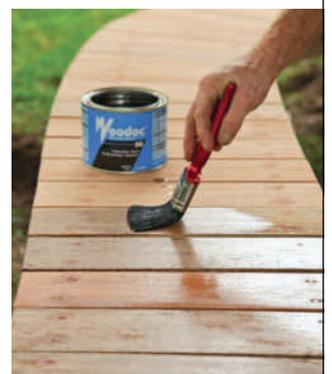
**6 Gi benken treolje.** Smør oljen raskt ut på benken, slip den godt inn i treet med våtslipepapir, og tørk av overskytende olje. Gjenta neste dag etter en lett runde med slipepapiret, og poler til slutt.
