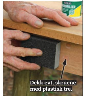
**5 Lameller og de synlige delene til sargen slipes.** Gi først treet en runde med korn 40 eller 60, alt etter hvor ru overflaten er. Alle kanter rundes lett. Følg opp med finere, og avslutt med korn 120.
