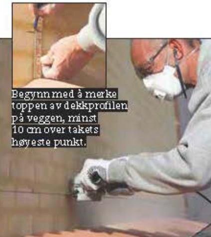
**1 Skjær et 2 cm dypt spor i veggens rett under sporet med en vinkelsslipper.** Følg streken du har målt opp. Før du monterer den selvklebende inndekningen, skal både taket og veggene rengjøres. Fei over veggene og taket grundig med en kost.
