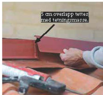
**5 Sett på plass dekkprofilen i sporet.** La profilene overlappes minimum 5 cm, og lim dem sammen med den tilhørende Wakaflextetningsmassen.
