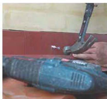
**6 Sett fast dekkprofilene til murveggen med spikerplugger** for hver 50 cm. Ikke sett spikerplugger i overlappingen mellom profilene.
