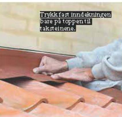
**4 Trekk av resten av filmen på baksiden av inndekningen.** Trykk fast inndekningen, men foreløpig bare på alle de høyeste punktene på takprofilen. Ellers trekker du inndekningen skjev.
