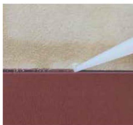
**8 Forsegle dekkprofilen med tetningsmassen,** etter at eventuell overskytende profil er skåret til i endene. Sørg for at overgangen mellom sporet og profilen blir helt tett.
