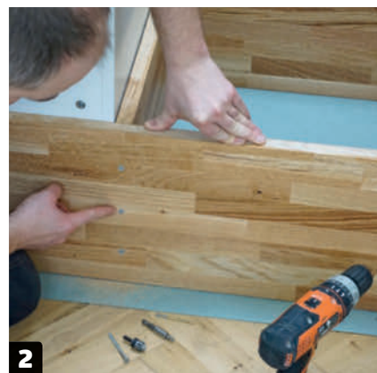
2 Bor for, og skru pladerne sammen med 5 x 60 mm skruer.
