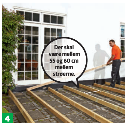
4 Brug et langt bræt som hjælper. Det holder afstanden mellem strøerne og sikrer, at de ikke vælter, mens du kiler op.
