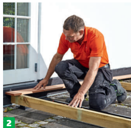
2 Lav en prøveoplægning. Vi sikrer os, at træterrassen får den ønskede højde i forhold til døren og soklen.
