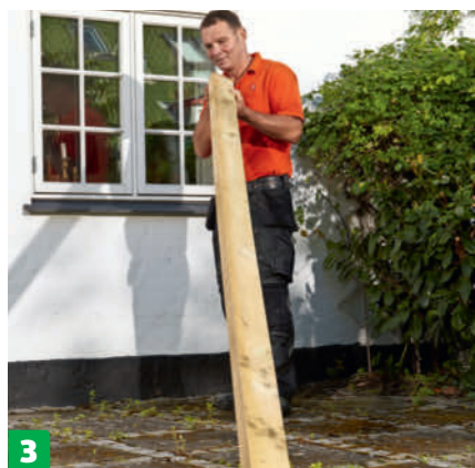
3 Tjek træet. Inden vi lægger strøerne ud, undersøger vi træet for skævheder. Hvis der er krumninger, er det vigtigt, de vendes opad. Strøerne lægges på højkant.
