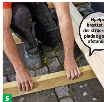
5 Mærk op til strøerne. Vi mærker op på hjælpebrættet, så vi ved, hvor alle strøerne skal være. Der skal være mellem 55 og 60 cm afstand mellem strøerne.
