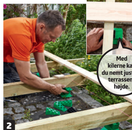
2 Ret strøerne op med Harpun-kiler. Når strøerne er rettet op inde mod huset, gør vi det samme ud mod græsset. Husk at tjekke, at de ligger vinkelret på huset.
