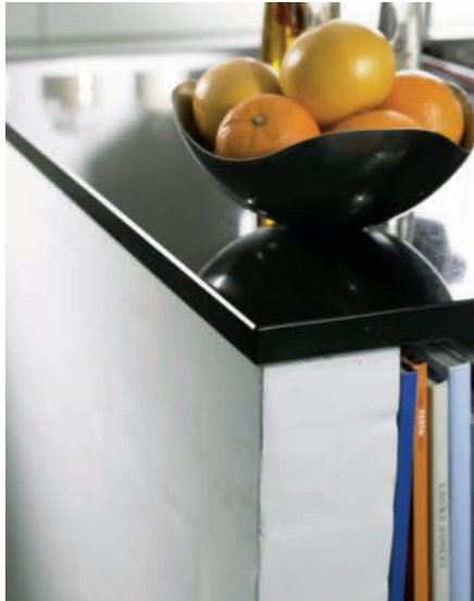
Den blankpolerede granitplade fuldender murværket. Den er både elegant og nem at holde ved lige med granitolie.
