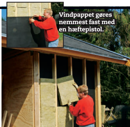
Revlerne fastgøres med 5 x 90 mm skruer. Du kan mærke gennem vindpappet, hvor reglarne sidder, som du skal fastgøre til.
