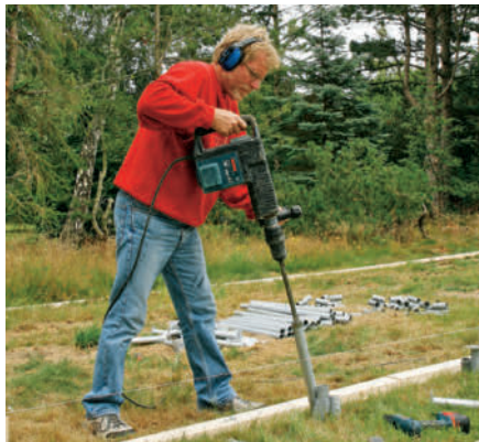
Adapteren sættes i beslaget igen, så du kan justere jordankeret. Når ankeret sidder korrekt, skruer du spyddet fast til ankeret.
