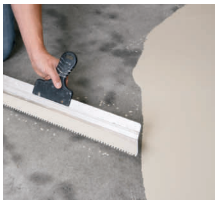
2 liter spartelmasse rækker i 2 mm's tykkelse til cirka 1 kvadratmeter.
