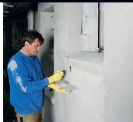
OBS! Væggen kastes med vand, inden slutpudsen trækkes på.
