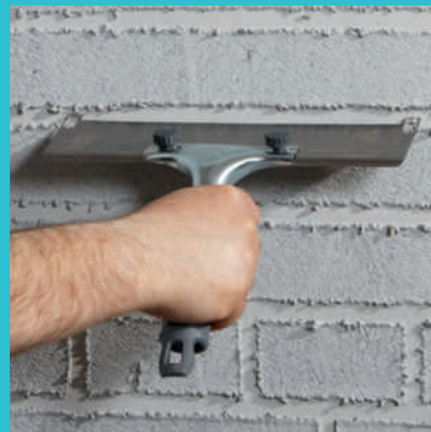
Med en specialskraber kan du trække mønster i din grundpuds, så væggen til sidst ligner tyndpudsede mursten.
