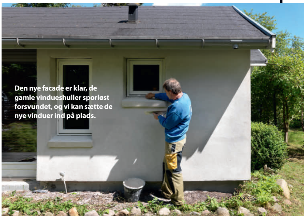
Et blødt filtsebræt uden riller kan også bruges, gerne med rullespand.
