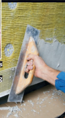
Sokkelnettet (F) hæftes på sokkelprofilet (A), mens profilet er rent og uden sandkorn.
