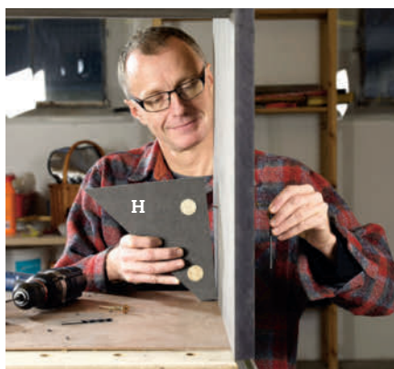
Kanalkanten (F) limes fast til bunden (E), mens den samles med siderne (B) med propper og skruer.
