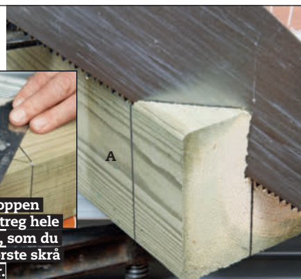
Afsæt midten på endekanten. Lav to skrå streger som vist, fra hjørnet og ud til midten.
