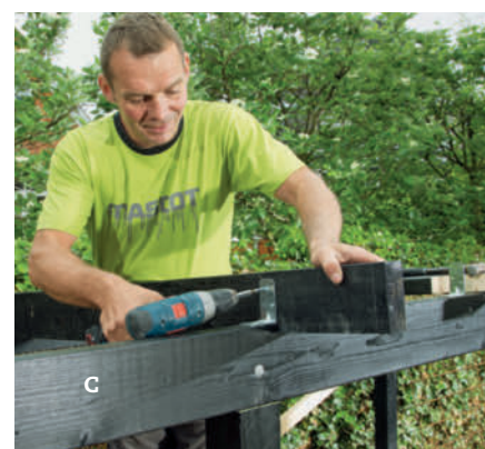
7 Skru spærerne fast. Brug beslagskruer og evt. en 5 x 90 mm skrue på den anden side, skruet skråt igennem spæret og ned i remmen.
