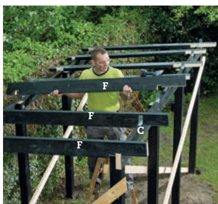
6 Læg spærerne på plads. Hakkene passer ned over de to remme. Vi sætter vinkelbeslagene på hver sin side af spæret hhv. forrest og bagest på spæret.
