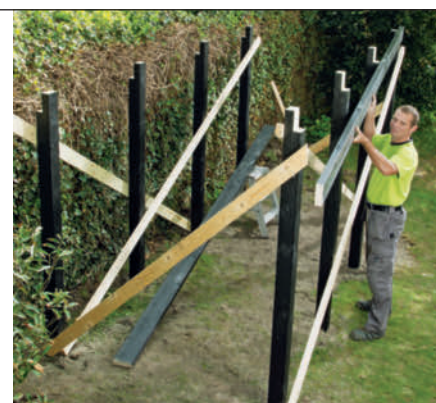
2 Løft remmen på plads. Remmen er skåret til, så den flugter med ydersiden på de yderste stolper i begge ender.
