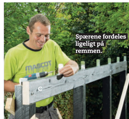
5 Sæt vinkler på de to remme (C). På den forreste rem sættes vinklerne på den ene side af spæret, og på den bageste rem sættes de på spærrets modsatte side med 5 x 40 mm beslagskruer.
