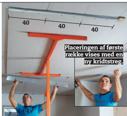
Ved båndstålet skrues med 25 mm gipsskruer til stål for hver 25 cm.
