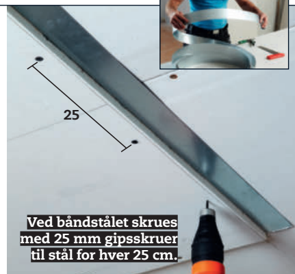
Båndstålet klippes ud af en lang rulle.
