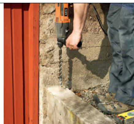
Pas på, at hullerne ikke sidder så yderligt, at betonen revner.
