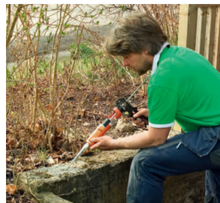
Patronen med klæber har en spids, hvor de to dele blandes på vej ned i hullet.
