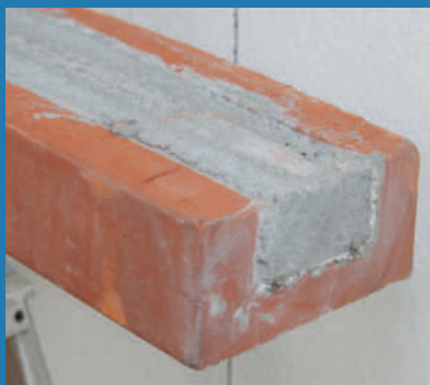
Der er støbt to armeringsjern ned i murstenene for at give dem styrke.
