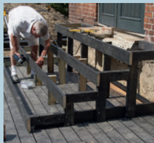
Foroven skrues en rem fast på muren, og ud fra den bygger tømreren resten af skelettet op.
