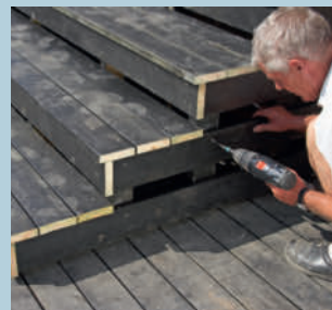
Siderne lukkes også af med terrassebrædder. Ikke tæt, det er kun pænt og sundt med lidt luft.
