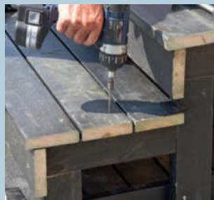
Trappens trin – og de lodrette stødtrin, som skelettet blev sat op med – er terrassebrædder.
