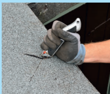
Skær et kryds over bulen eller hullet. Skær mindst 5 cm for langt i begge ender.
