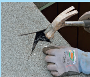
Luk hullet, og søm fligene godt fast til underlaget med tagpapsøm.
