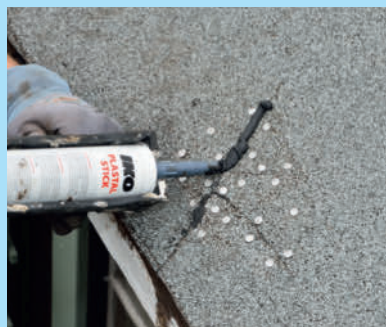
Læg yderligere et par striber asfaltklæber hen over sprækkerne.
