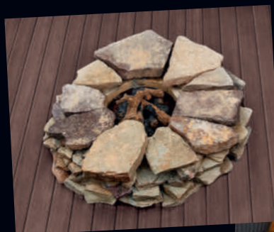
Et bålsted af flade sten stablet med en diskret mørtel til at holde sammen på tingene og beskytte træværket.
