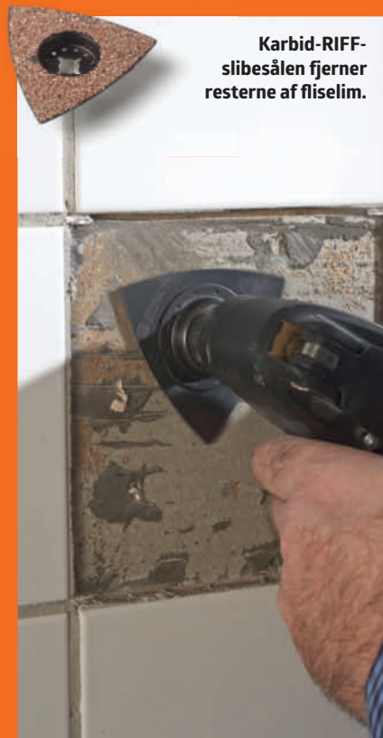
Karbid-RIFF-segmentklingen fjerner fugen.
