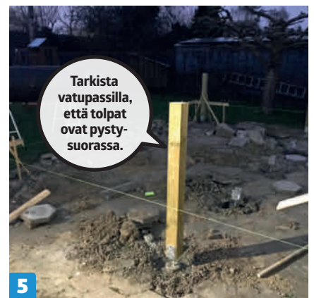
5 Asenna tolpat tolppakenkiin ja ruuvaa ne kiinni 10x60 millin kansiruuveilla. Pidä huoli, että tolpat ovat tarkasti pystysuorassa.
