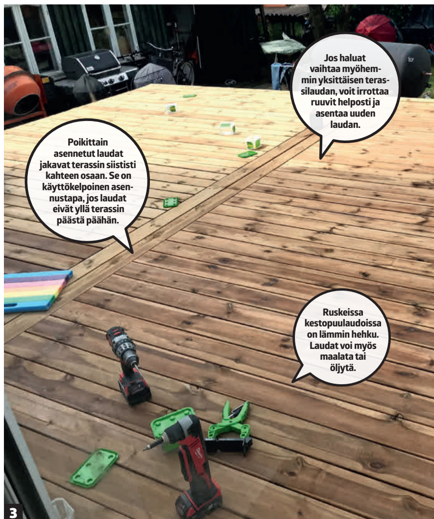
3 Asenna loput laudat samalla periaatteella. Voit varmistaa linjalangalla, että laudat ovat suorassa. Terassilaudat eivät ole yleensä aivan suoria, joten joka viides tai joka kymmenes lauta kannattaa asentaa mittaamalla. Muuten laudat voivat mennä vinoon ja terassista tulee mutkaisen näköinen.
