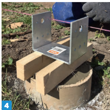
4 Kaada betoni putkiin ja tue tolppakengät parilla kapulalla. Muuten tolppakengät vajoavat, ennen kuin betoni kovettuu. Voit asentaa tolpat vuorokauden kuluttua.
