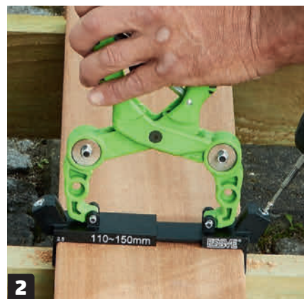
2 Ruuvaa terassilaudat (C) kiinni ruostumatomilla terassiruuveilla. Tässä käytetään Essven HDS-asennustyökalua.
