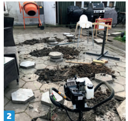
2 Merkitse tolppien paikat ja kairaa niiden kohdalle noin metrin syvyisen kuopat. Voit käyttää käsin väännettävää maakairaa tai vuokrata tehokkaan moottorikairan.
