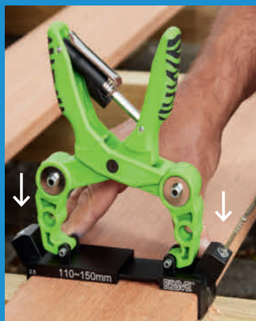
Asenna ruuvit reikiin ja väännä ruuvit puuhun 45 asteen kulmassa. 250 ruuvipaketti ruostumatomia 4,8x50 millin terassiruuveja maksaa noin 60 euroa.
