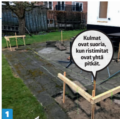
1 Tee neljä puukehikkoa ja viritä niiden välille linjalangat terassin reunojen kohdalle. Tarkista terassin ristimitat kelamitalla ja siirrä lankoja, kunnes mitat täsmäyvät millilleen.
