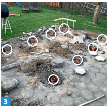
3 Upota kuoppiin muoviputket siten, että niiden pinta jää pari senttiä maan pinnan yläpuolelle. Sekoita seuraavaksi betoni.
