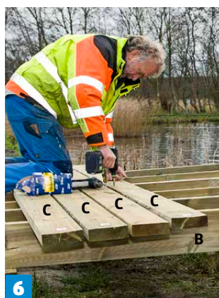
6 Ruuvaa jokainen kansilankku (C) kiinni niskoisiin (B) kahdella 5x100 millin ruuveilla. Jätä lankkujen väliin noin sentin raot.
