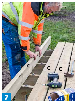
7 Koverra lankkujen pohjaa kierretankojen kohdalta sen verran, että mutterit mahtuvat paikalleen. Voit käyttää talttaa tai 30 millin reikä- tai oksaterää.
