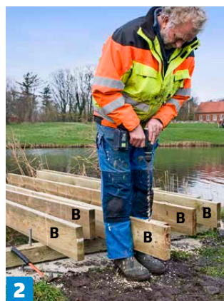
2 Poraa niskoisiin (B) 14-milliset reiät. Kohdista keskilankkujen reiät 23 senttiä, seuraavien 16 senttiä ja uloimpien 9 senttiä lankun päästä. Poraa suoraan.
