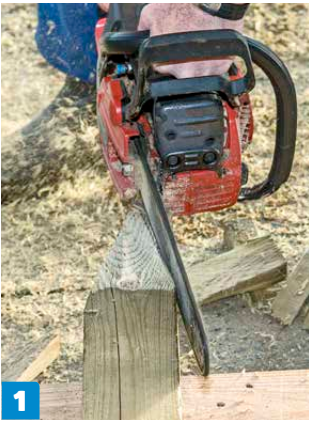
1 Teroita pohjapaalun (D) alapää moottorisahalla.
