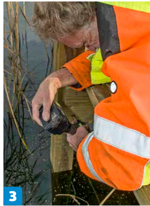
3 Ruuvaa niska kiinni paaluun. Muista irrottaa ruuvit, ennen kuin jää alkaa liikutella paalua!
