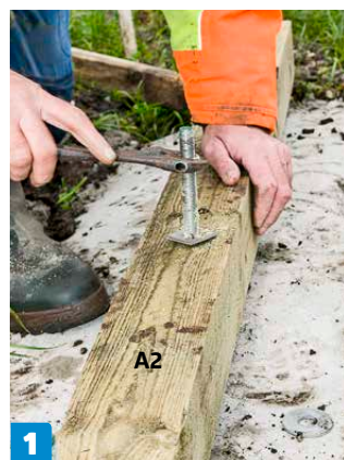
1 Kiinnitä lyhyt palkki (A2) betonista nouseviin kierretankoihin. Palkin alla olevat mutterit helpottavat korkeuden säätämistä.
