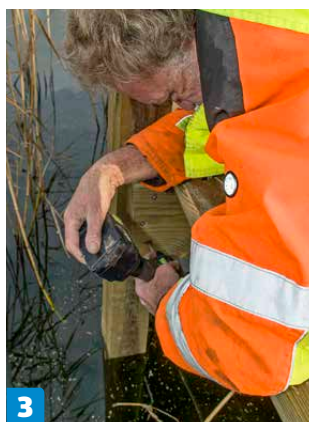
3 Tilfareren skrus fast til pålen, så bryggen blir helt stabil. Men husk å fjerne skruene før isen begynner å dytte på pålen!
