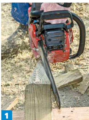
1 Fortøyningspålen (D) spisser vi til med en motorsag i den enden som skal ned i sjøen.
