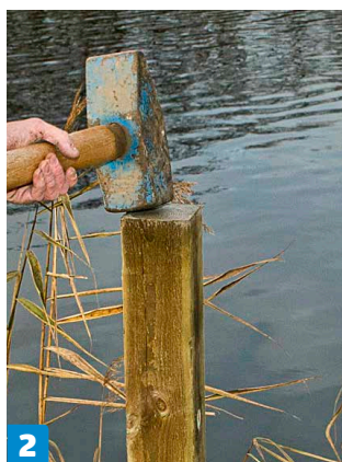
2 Fortøyningspålen (D) bankes ned i sjøbunnen kloss inn mot en tilfarer. Bank til den ikke kan komme lengre ned.
