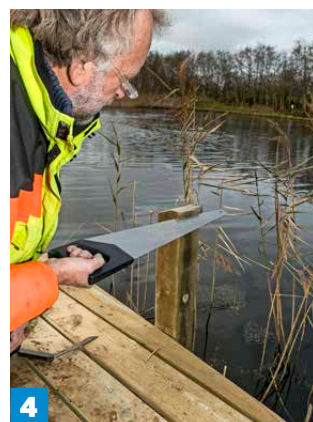
4 Toppen av fortøyningspålen sages til med skrå snitt, slik at regnvannet kan renne av.
