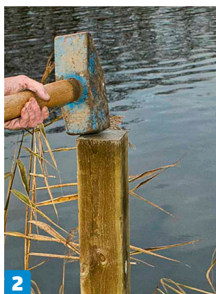
2 Fortøjningspælen (D) bankes ned i søbunden klos op ad en strø, til den ikke kan komme længere ned.
