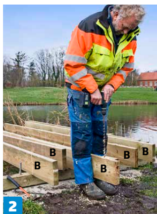
2 Gennem strøerne (B) borer du i de to midterste strøer bores 23 cm, i de næste 16 cm og i de yderste 9 cm fra enden. Få hjælp til at bore lodret.
