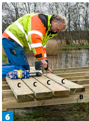
6 Så skruer vi dækket (C) fast på strøerne (B) med 5 x 100 mm skruer, 2 skruer i hver strø. Mellem dæksplanker holder vi 10 mm luft.
