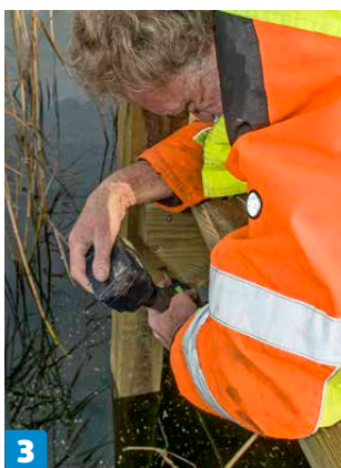
3 Strøen skrues fast til pælen, så broen er helt stabil. Men husk at fjerne skrueerne, før isen begynder at skubbe til pælen!
