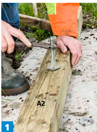
1 Den korte bjælke (A2) gøres fast på de faststøbte gevindstænger. Møtrikker på undersiden løfter den fri af blokken og gør det nemt at justere højden.
