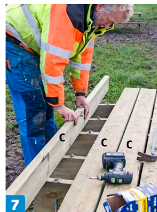
7 Vi må "grave" lidt i undersiden af de planker, som sidder over gevindstængerne. Det kan klares med et stemmejern eller et 30 mm forstnerbor.
