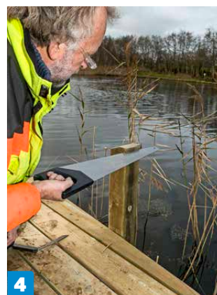
4 Toppen af fortøjningspælen saves til med skrå snit, så regnvandet vil løbe af.
