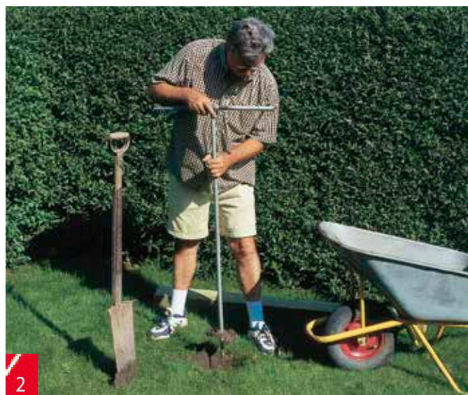
Pylväille kaivetaan reilun puolen metrin syvyiset kuopat. Routiva maa pitää salaojittaa. Pehmeään maahan kuopat voi tehdä maakairalla.
