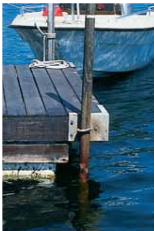
Ostolaitureista kelluvat ponttonilaiturit ovat yleisimpiä. Ne pitää tukea paaluilla tai vaijereilla.
