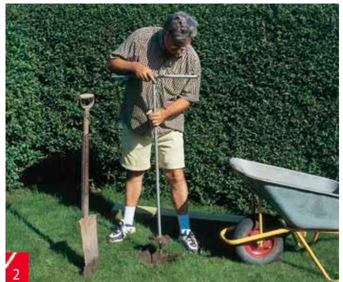
Om det är lös jord eller sand kan du använda ett jordborr att göra hålet med. Men du tvingas nog gräva en del i alla fall.
