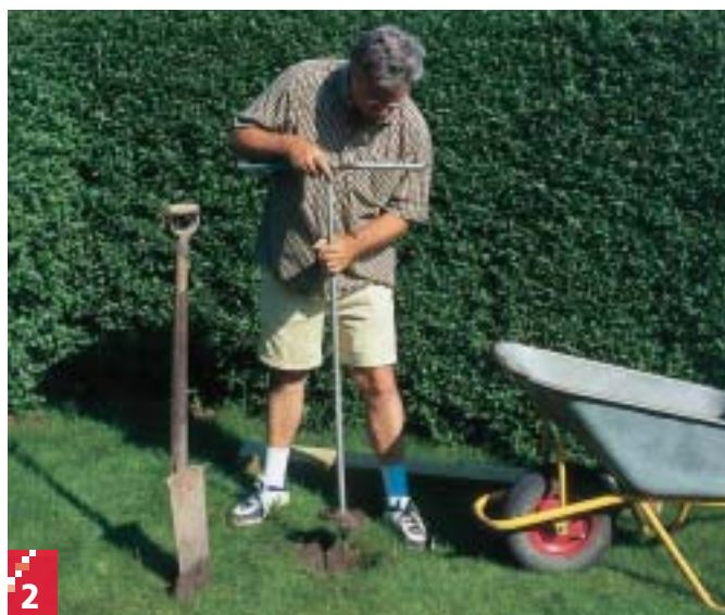
Når stolperne skal graves ned, kan du med fordel leje specialværktøj i et byggemarked, fx et jordbor og evt. en drænspeade.
