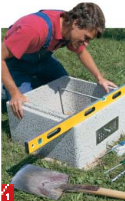
1 Græstørv og muldjord graves væk, hvor ovnen skal stå. Hullet fyldes med grus og stemples, og det første element anbringes. Skal ovnen stå her i mange år, kan du støbe betongrundament.
