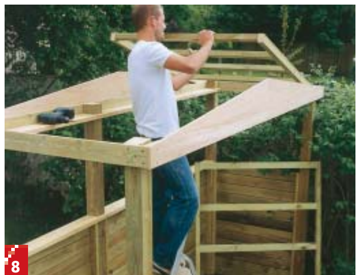
8 Tegn de skrå snit af fornedden på lægterne (O) ved at holde dem på plads. Sav dem til med en elektrisk stiksav, og saml så de to lægtekonstruktioner af lægterne (O) og (P). Sørg for at placere de næstøverste tværlægter, så de ligger midt over tagpladernes samlinger.
