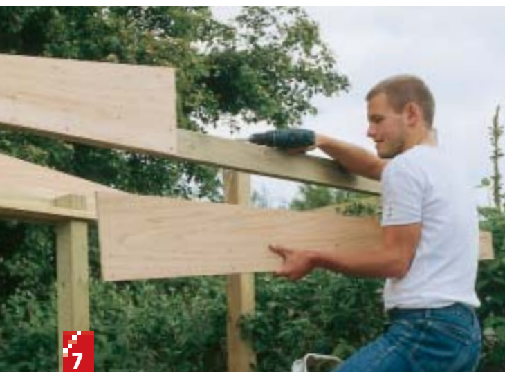
7 Afkort de to midterste stolper (A) i plan med overkanterne af bjælkerne (B). Sav de fire gavplader (D 1 ) ud efter målene på tegningen, og skru dem på bjælkerne med 5,0 x 50 mm skrue. Afkort derefter hjørnestolperne (A) i flugt med gavpladerne.
