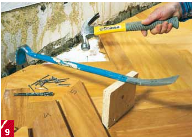
9 De første stave, der monteres, trykkes på plads med et koben –spændt op med en klods. Stavene gøres fast med søm til undergulvet.
