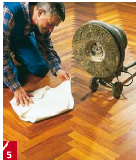
5 Gulvet poleres nu efter med en gulvklud, der er lagt under en tør polerskive. Fold hjørnerne ind over skiven, inden rondelsliberen sænkes ned. Kluden suger også overskydende olie.
