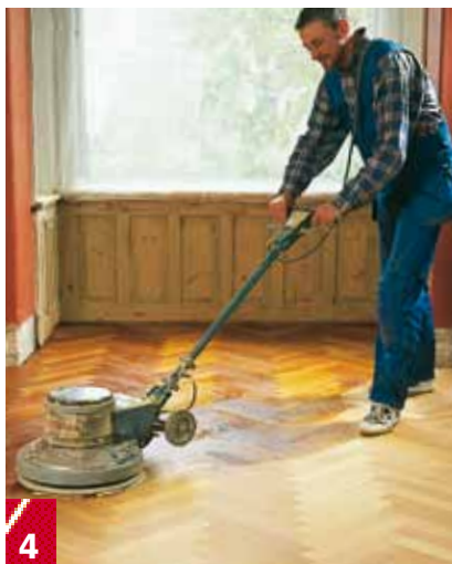
4 Fordel nu olien med polerskiven, og tilføj mere, indtil cirka 10 kvadratmeter er blevet behandlet. Arbejd olien ned i overfladen med maskinen – område for område.
