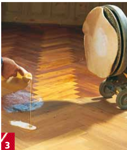
3 Når gulvet er slebet plant og støvsuget, er det parat til oliering. Ryst dunken, og hæld 1-2 dl olie på gulvet ad gangen. Rondelslibemaskinen forsynes med en hvid pad (polerskive).
