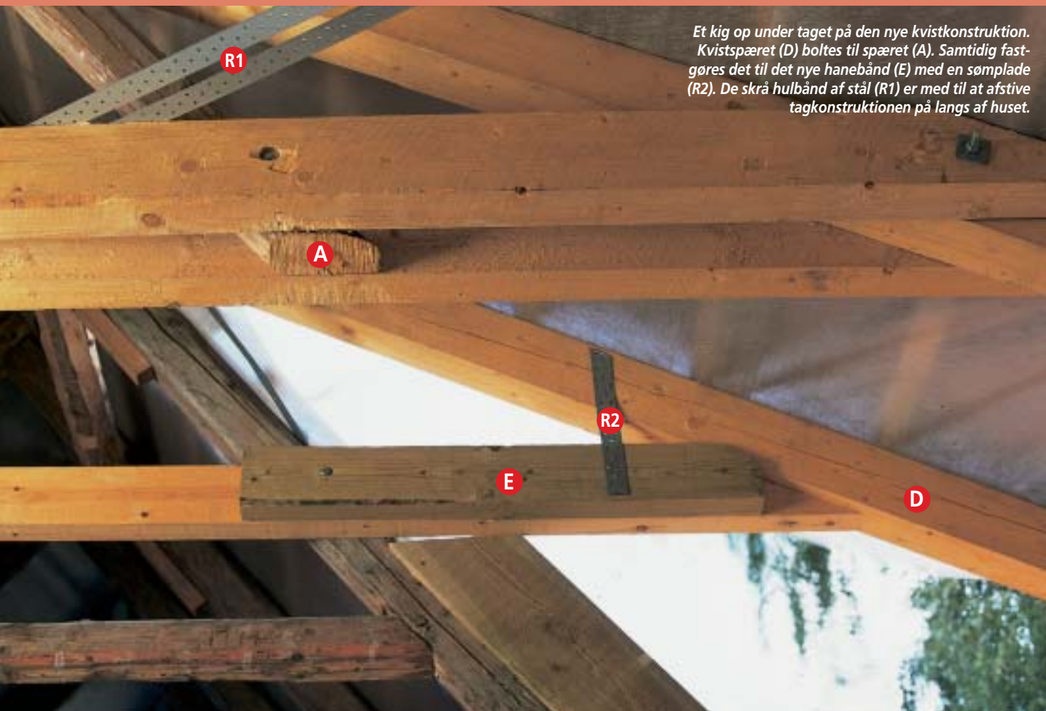
Sammenhold dette billede med tegningerne, og du har et ganske godt overblik over kvistens opbygning. Her bliver det gamle spær skåret af ud for den nye kvist.
