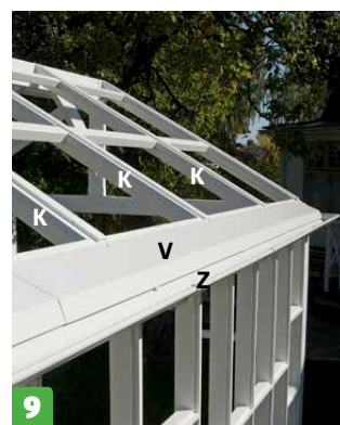
9 Forkantbordet (R) skrues på enden av sperrene (K), og rennekroker og takrenne settes på. Til slutt settes takfotbeslaget på plass. Det sikrer at alt vann føres ned i takrennene.
